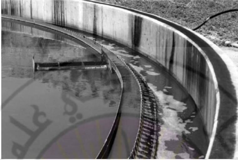
الشكل 12-6 خزان الترسيب النهائي.
