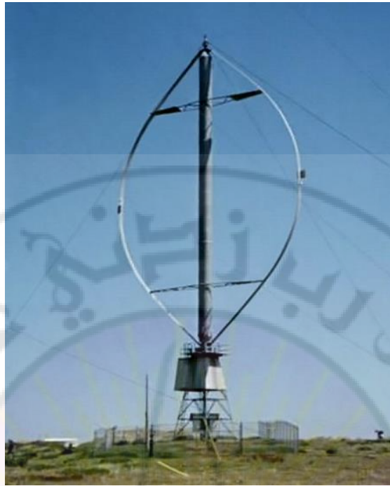
الشكل (10-6) عنفة داربوس ذات المحور الشاقولي استطاعة [kW] 30 وقطر دوران [m] 13
