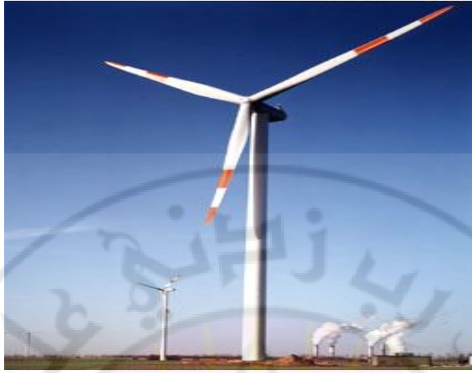
الشكل (5-10) عنفة ربحية حديثة بثلاث أجنحة باستطاعة 600[kW]
