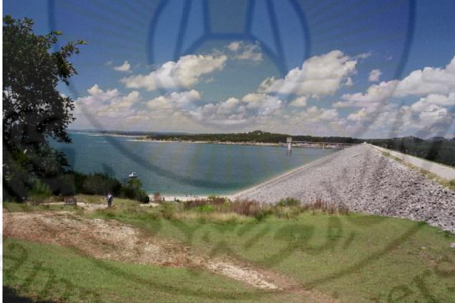
الشكل (٢١-٤) حماية حجرية ملقاه بشكل عشوائي على مقدمة السد Dumped rock riprap
