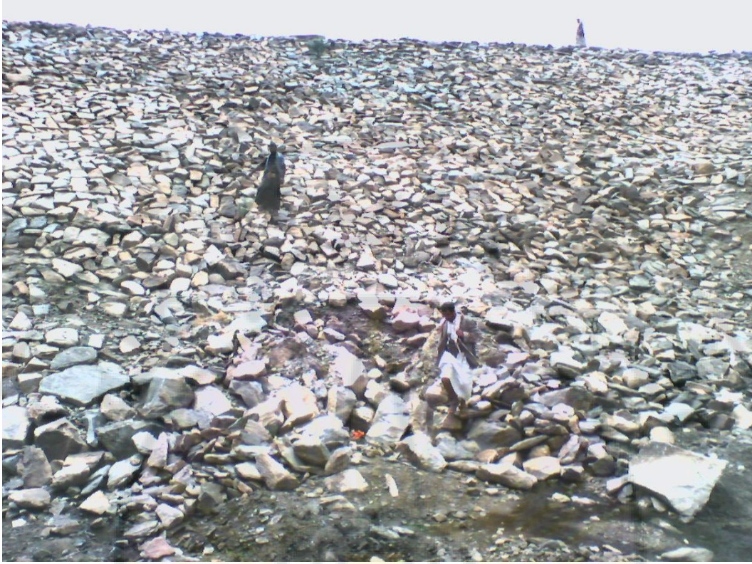
الشكل(٤-٢٢) حماية حجرية رص يدوي hand placed rock riprap
